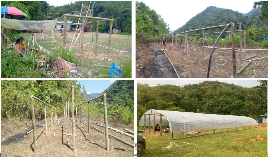
Rajah 8.2. Proses pembangunan Social Lab
