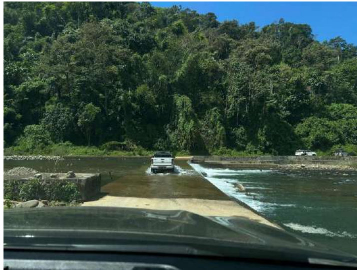
Rajah 1: Jambatan rendah (low level crossing) yang menjadi laluan utama penduduk Kg Sinansag Sumber: Gambar diambil oleh Mc Jeanet pada 15 Mac 2025
