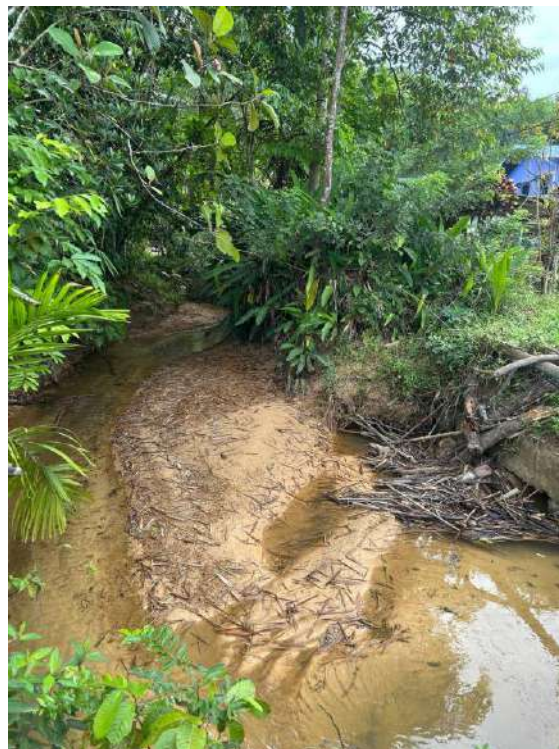
Rajah 4: Parit utama di Kampung Rongolis yang mengalami mendapan tanah dan sisa organik yang menghalang aliran air.
