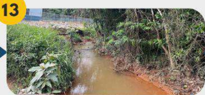
24 Januari 2025 Lawatan Tapak 3: Kawasan Longkang Culvert
